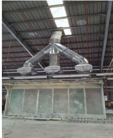
Hình 23. Hệ thống xử lý khí thải buồng sơn màng khô 3 quạt hút
