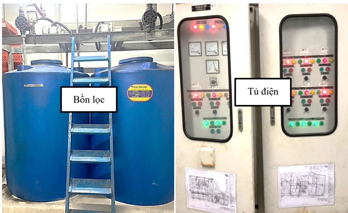
Hình 16. Các bể xử lý của Trạm xử lý nước thải công suất 1.255,5 m 3 /ngày đêm
