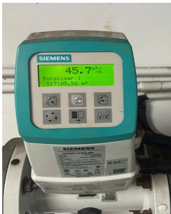
Hình 19. Hình ảnh thực tế trạm quan trắc tự động liên tục đã được lắp đặt
