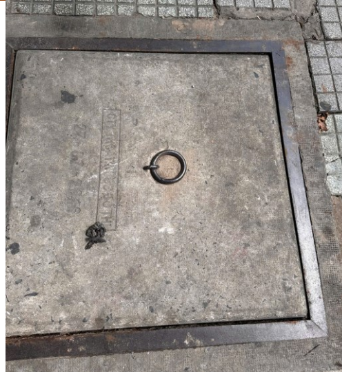
Hình 3. 2. Hố ga đấu nối nước mưa tại Cơ sở
