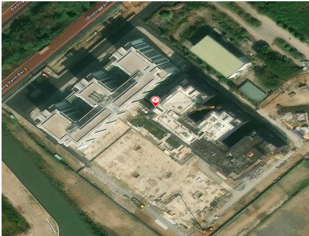
Hình 18. Vị trí cửa xả ống khói máy phát điện
