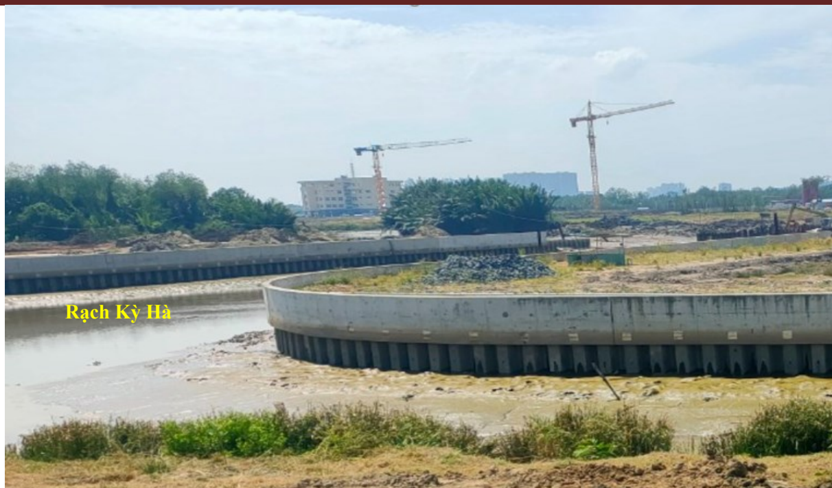
Hình 6. Hình ảnh thực tế tại Rạch Kỳ Hà
