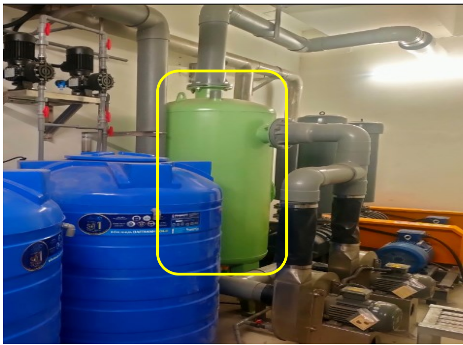
Hình 22. Hệ thống xử lý mùi hôi khí thải
