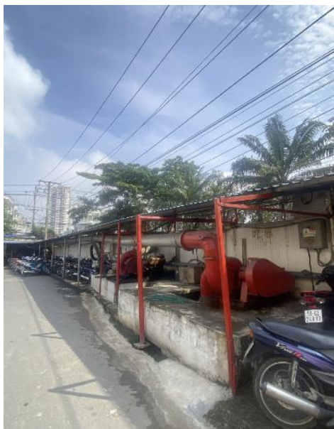
Hình 6 – Trạm bơm thoát nước mưa và điểm đầu nối nước mưa của cơ sở
