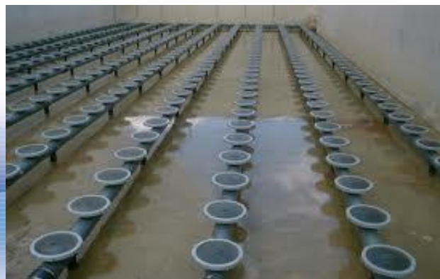
Hình 4.9 Hệ thống phân phối khí (Minh họa)
