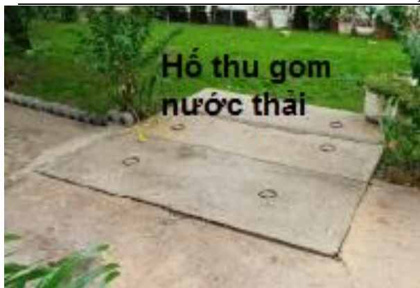
Hình 3.5. Hồ ga thu gom nước thải trước XL
