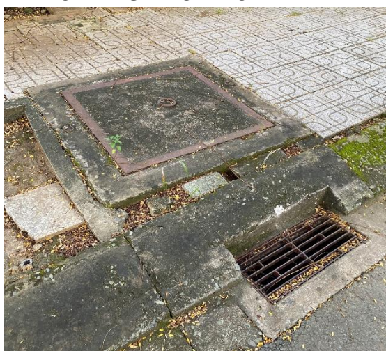
Hố ga thu gom nước mưa nội bộ
