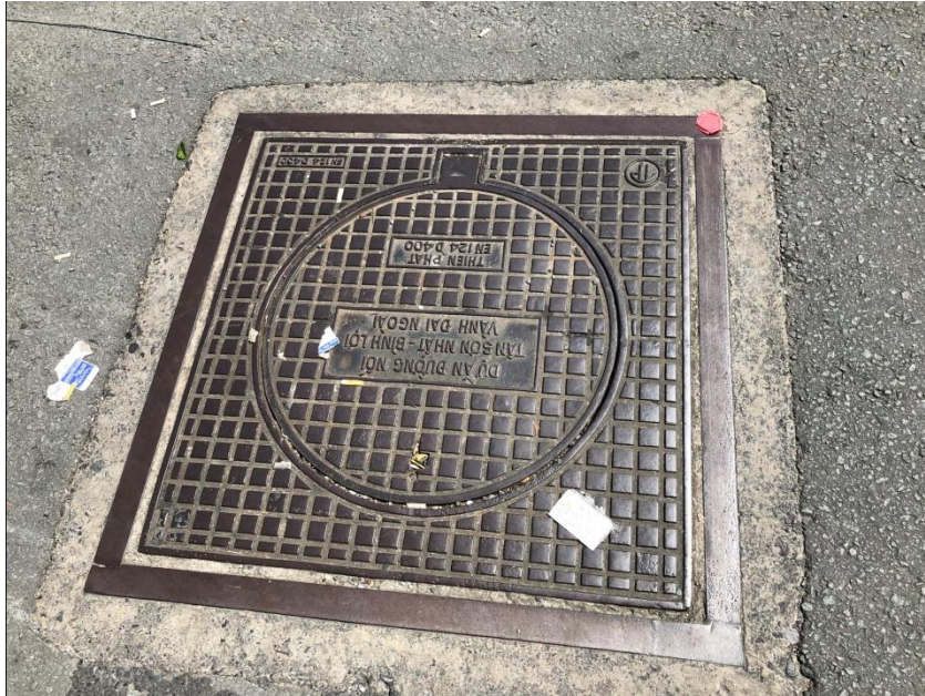
Hình 3. 6. Hố ga đầu nối nước thải
