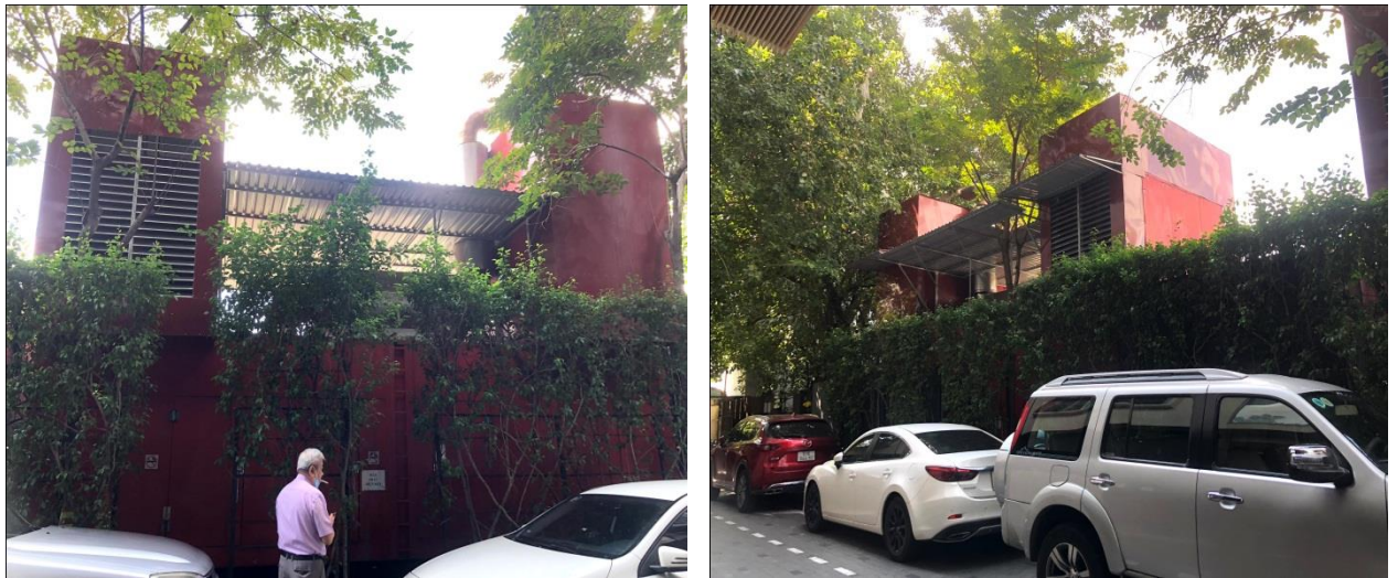
Hình 3. 14. Ống khói máy phát điện tại Cơ sở
