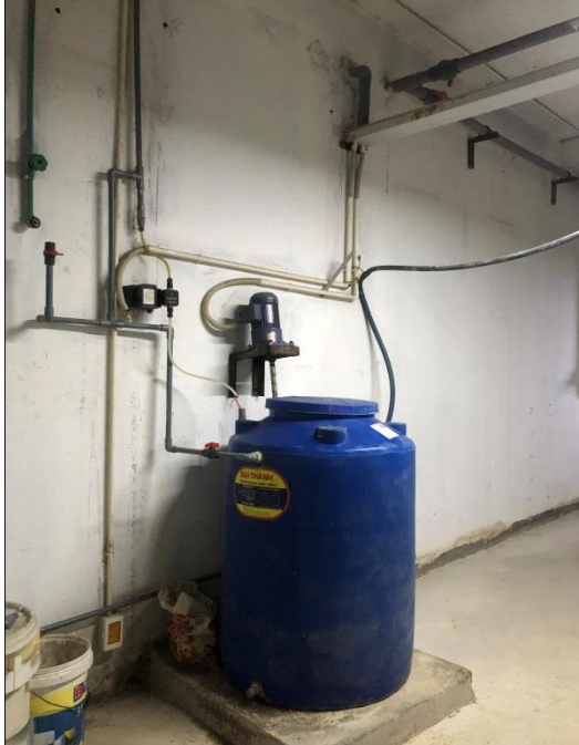
Hình 3. 10. Nơi để hóa chất và tủ điều khiển HTXLNT hầm B2
