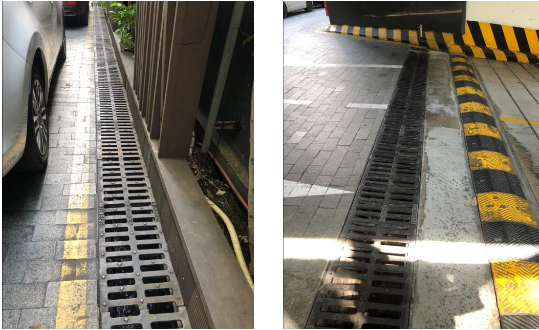
Hình 3. 2. Tuyến thu gom, thoát nước mưa
