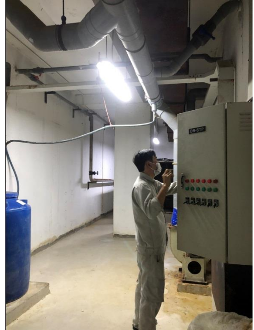
Hình 3. 10. Nơi để hóa chất và tủ điều khiển HTXLNT hầm B2
