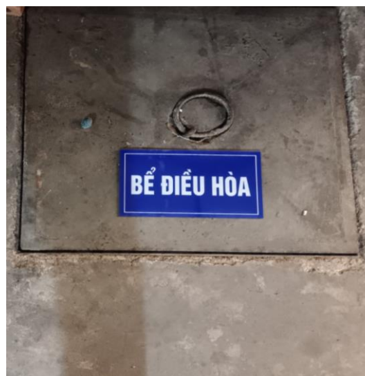
Bể điều hòa
