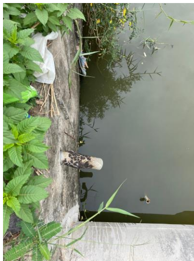
Hình PL10. Miệng xả nước thải
