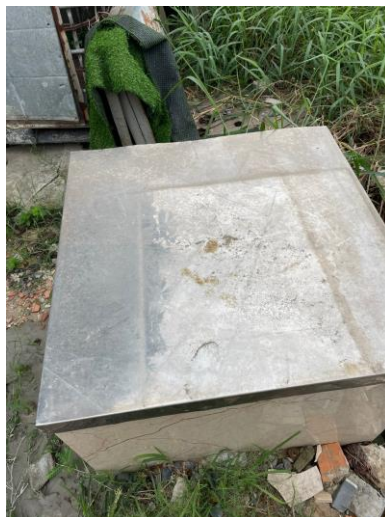
Hình PL8. Hố ga lấy mẫu nước thải
