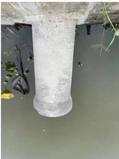
Hình PL9. Miệng xả nước mưa
