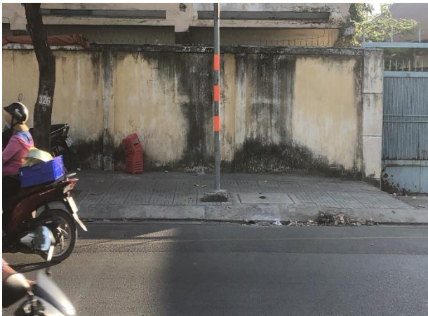
Tuyến cống thoát nước mưa 1
