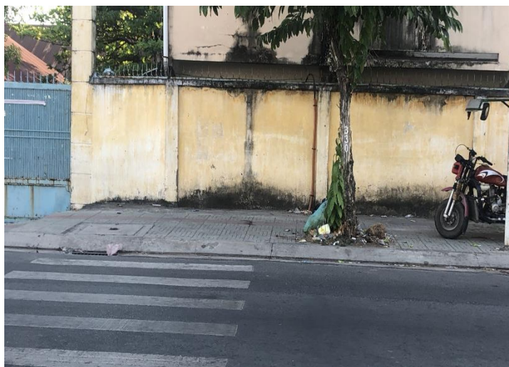
Hình 4.5. Tuyến cống thoát nước thải trên đường Lê Lợi
