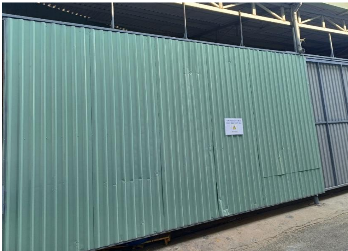
Hình 3.14. Khu vực lưu chứa chất thải rắn công nghiệp thông thường
