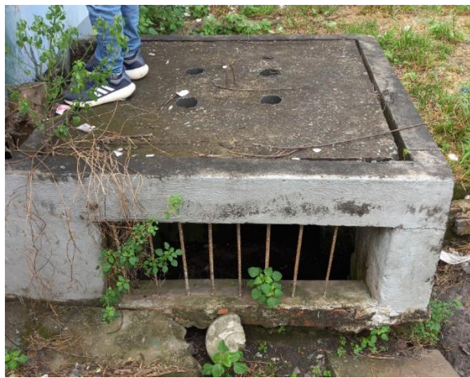
Hình 3.3. Hố ga đầu nối nước thải cuối cùng bên trong nhà máy
