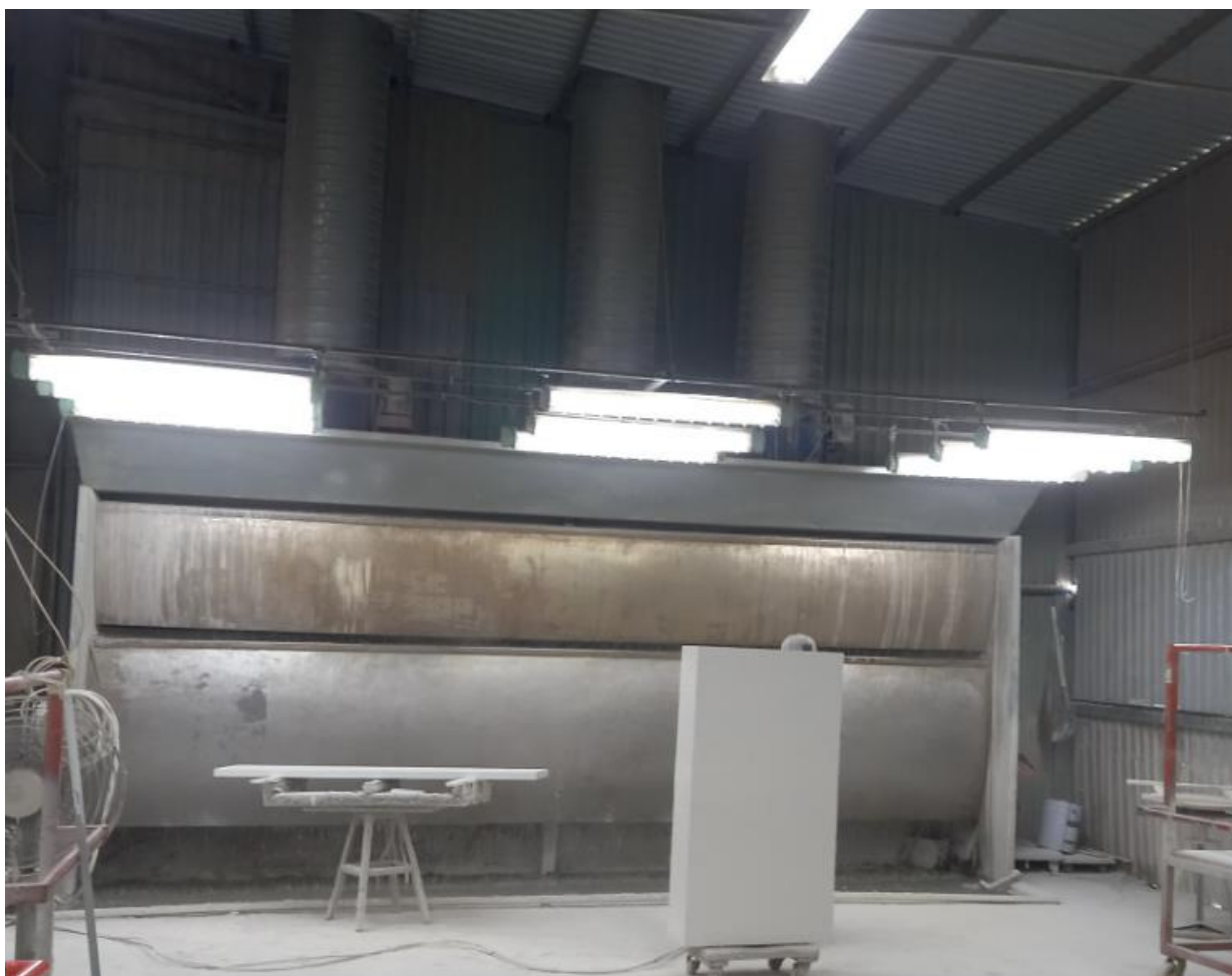
Hình 3.10. Buồng lọc bụi sơn bằng màng nước
