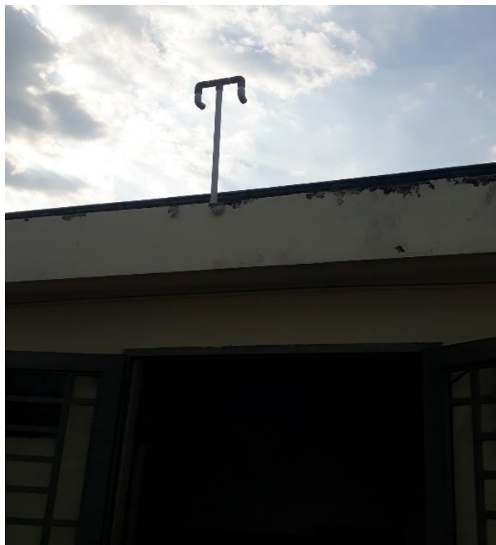
Hình 3. 8. Ống thoát khí thải (mùi) từ hệ thống xử lý nước thải
