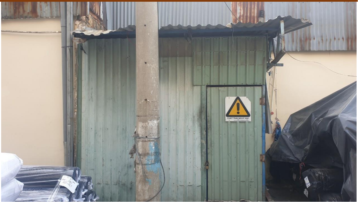
Hình 3.8. Kho chứa chất thải nguy hại tại Cơ sở
