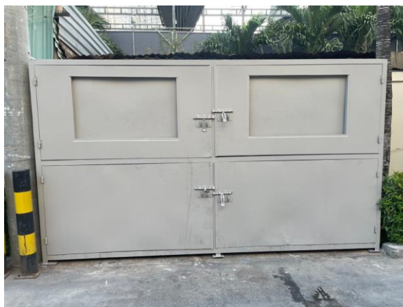
Hình 3.7. Hình ảnh khu chứa rác thải sinh hoạt
