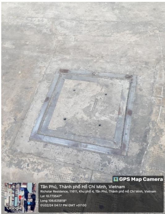
Hố ga đầu nối vào hệ thống cống thoát nước thải trên đường Hòa Bình
