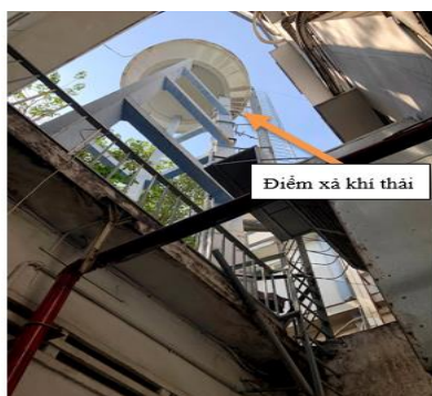
Vị trí ống khói MPĐ1 công suất 500KVA
