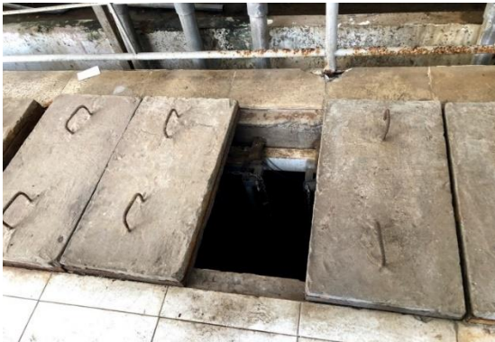
Bể điều hòa
