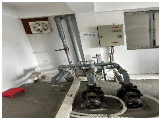
Bơm nước sau xử lý số 1
