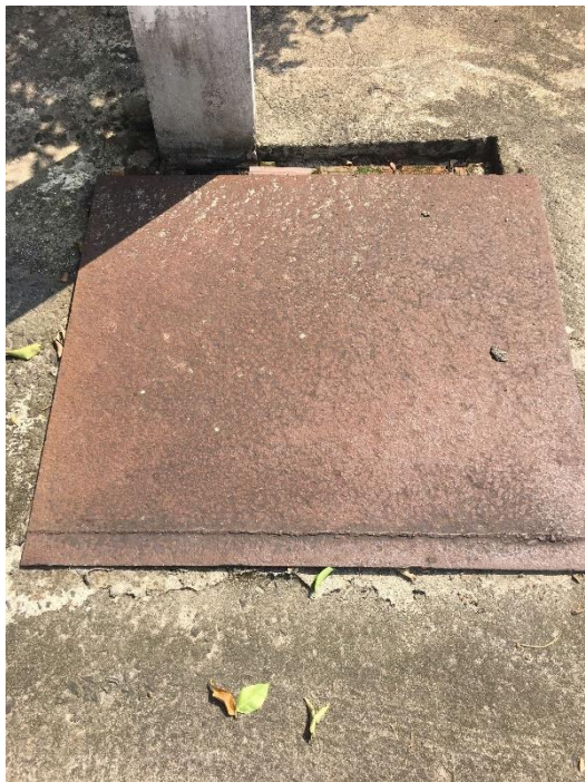
Hình 3.2 Hình ảnh mương thoát nước mưa
