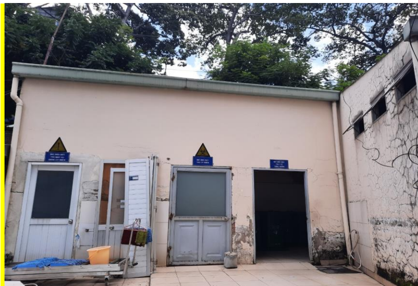
Hình 12: Hình ảnh nhà chứa chất thải tập trung của Bệnh viện
