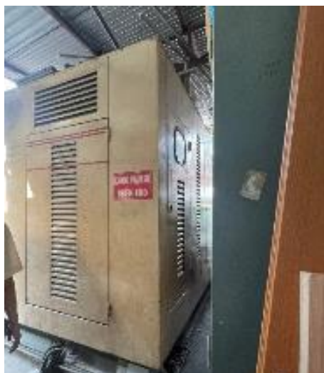
Máy phát điện dự phòng công suất 196 kVA tại khu B
