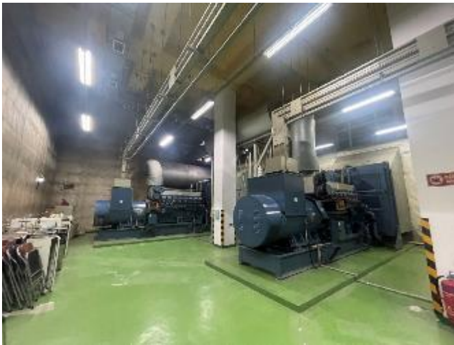
02 Máy phát điện dự phòng công suất 2.235 kVA tại khu A
