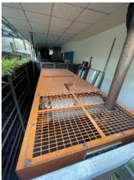
Máy phát điện dự phòng công suất 500 kVA tại khu B
