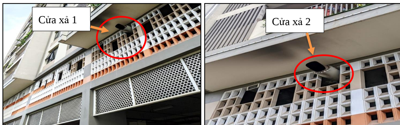
Hình 11. Hình ảnh cửa xả của ống thoát khí thải máy phát điện
