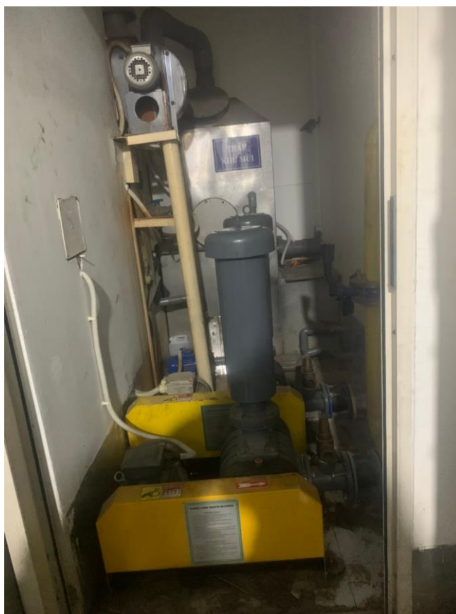
Hình 12. Hệ thống tháp khử mùi phát sinh từ hệ thống XLNT của khách sạn
