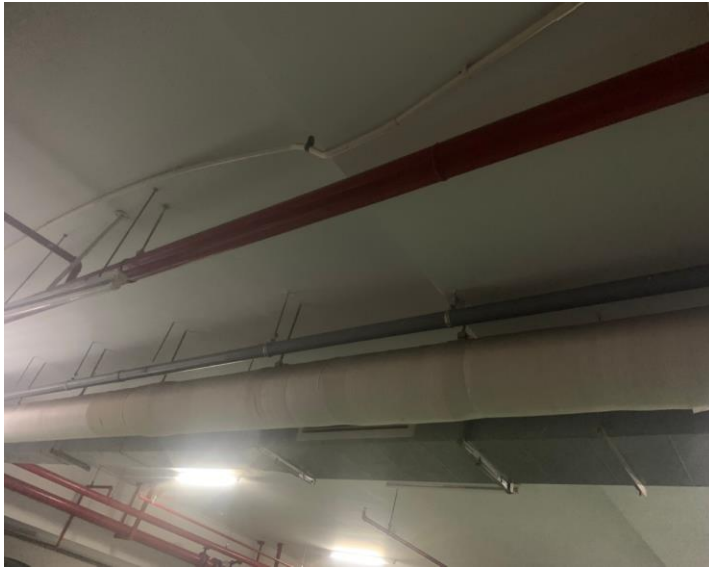
Hình 7. Đường ống thoát nước thải sau xử lý
