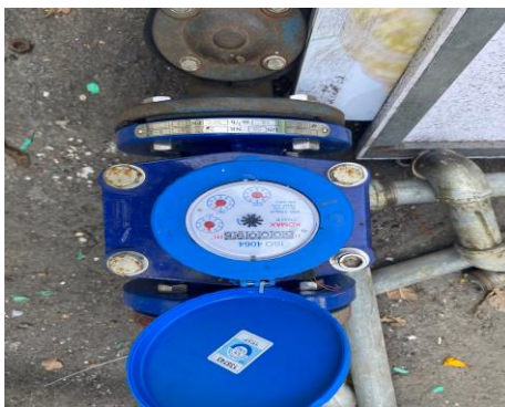
Hình 14: Đồng hồ đo lưu lượng nước thải sau HTXL của Siêu thị
