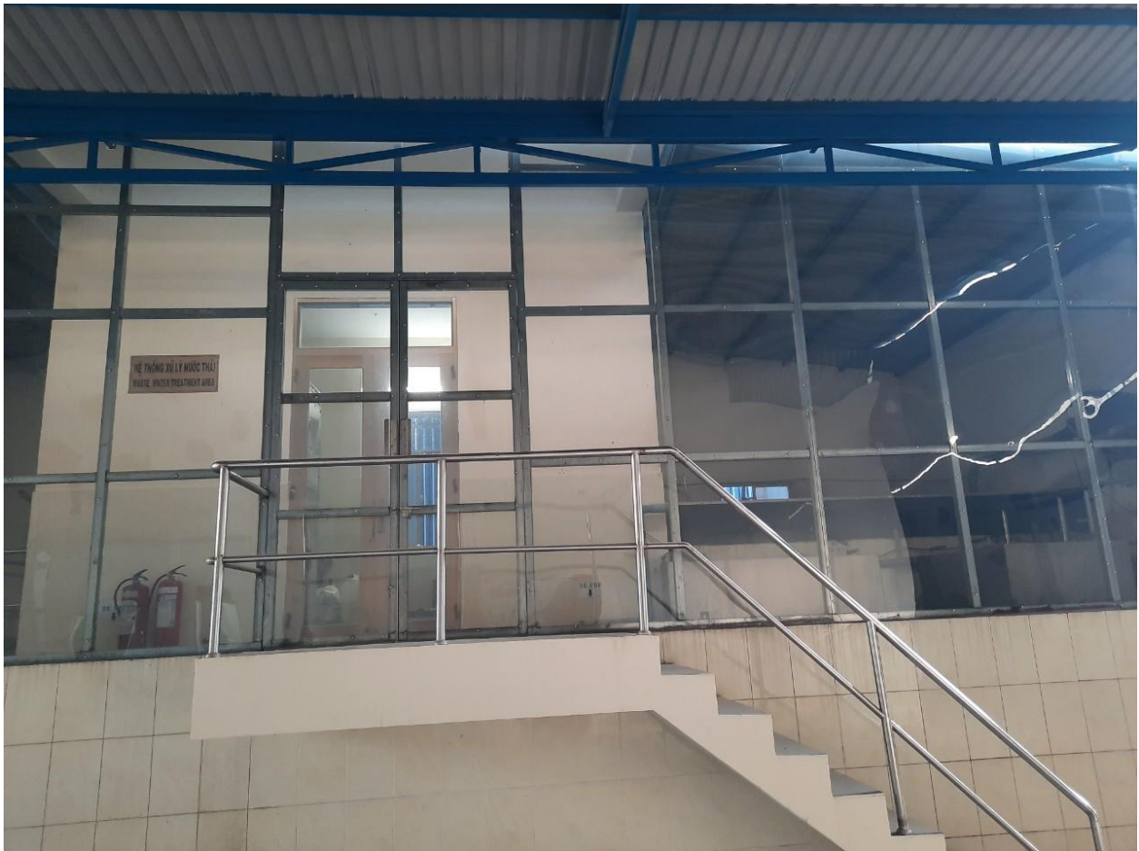
Hình 3.6: Khu vực HTXLNT tập trung, công suất: 90 m 3 /ngày
