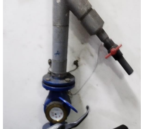
Hình 10. Hồ ga thoát nước thải và đồng hồ đo lưu lượng nước thải của HTXLNT tại Block B
