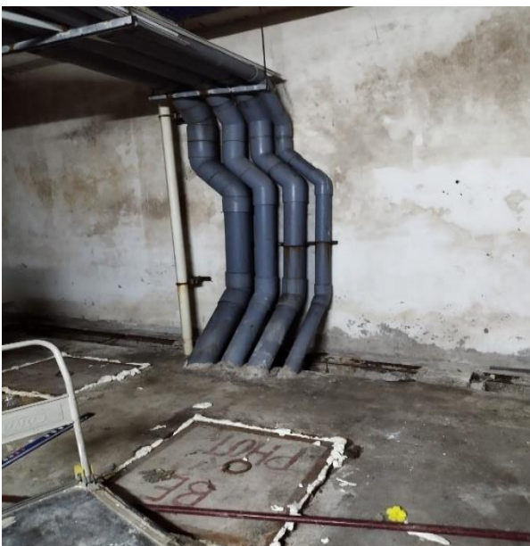
Hình 12. Hồ ga thoát nước thải HTXLNT tại Block D
