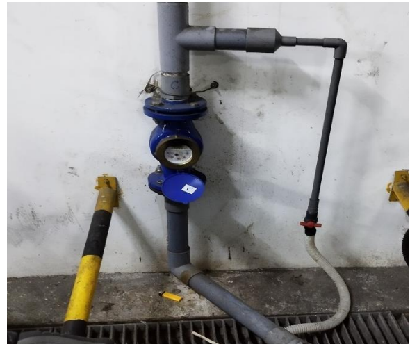
Hình 11. Hồ ga thoát nước thải và đồng hồ đo lưu lượng nước thải của HTXLNT tại Block C
