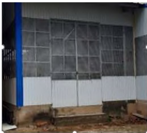
Hình 3.10: Nhà để máy phát điện dự phòng
