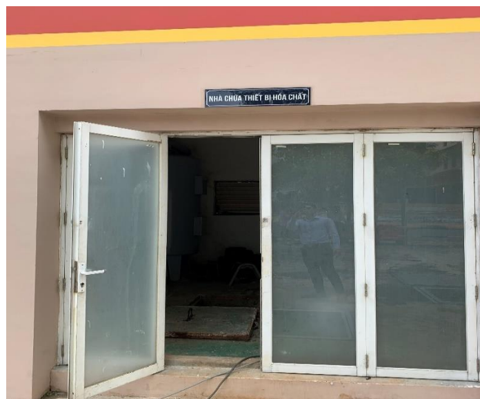
Hình 3.6. Trạm xử lý nước thải tập trung 2.500m 3 / ngày đêm
