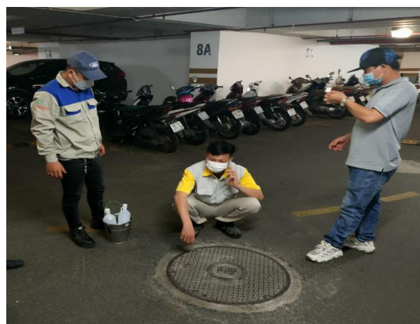
Nắp thăm tiêu biểu tại 1 bể điều hòa của trạm 400 m 3 /ngày – Khu AB
