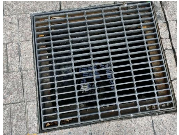
Hố ga thu nước mưa tại cơ sở
