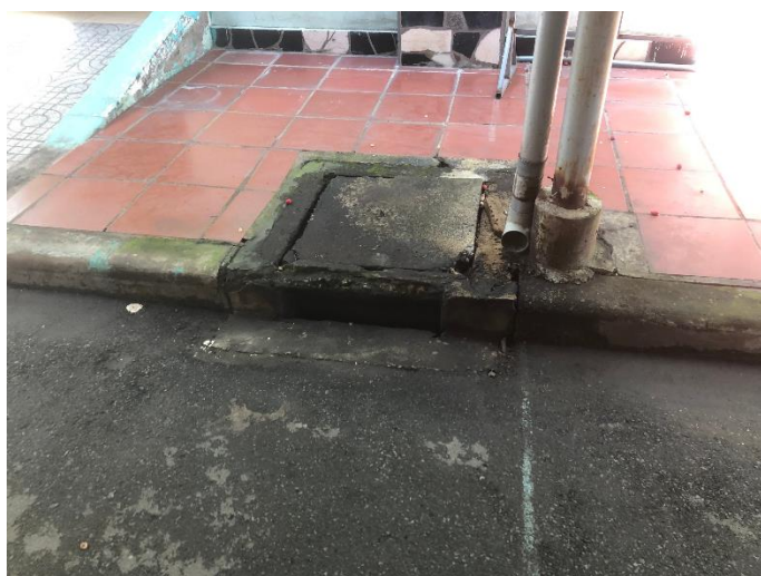
Hố ga nước mưa trong dự án
