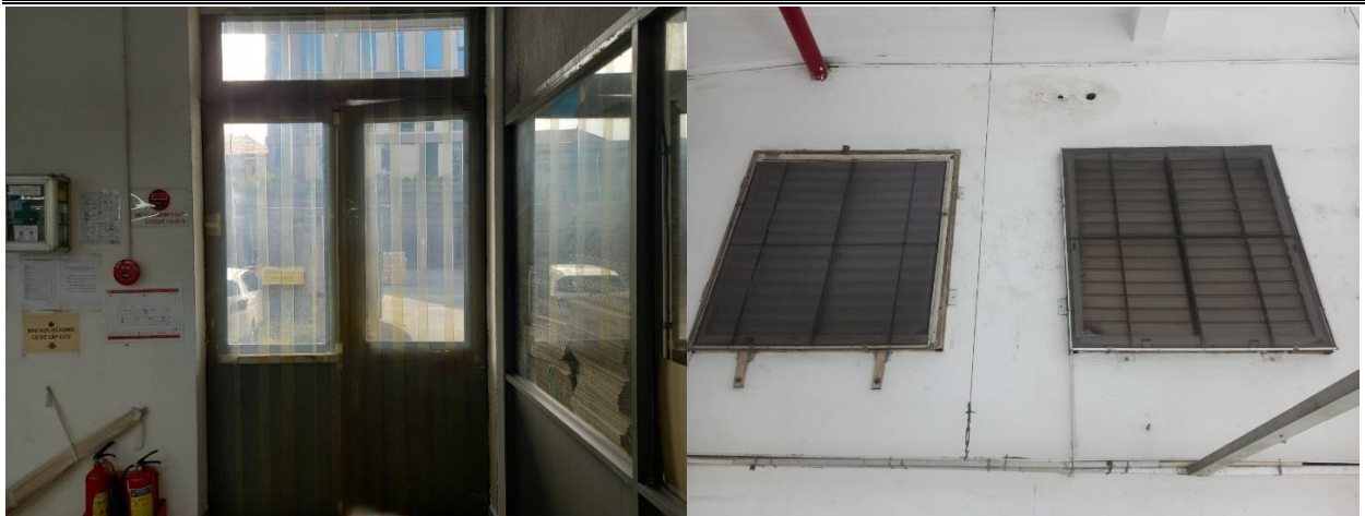
Hình 3.16. Bố trí màn nhựa và lưới lọc tại xưởng sản xuất
