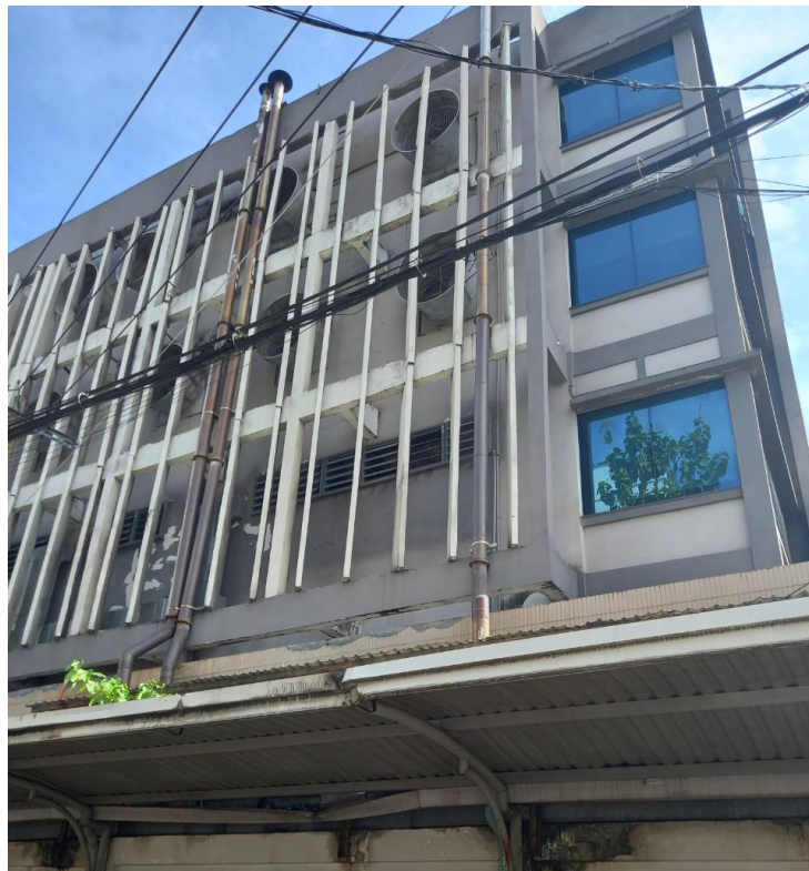
Hình 3.10. Ống khói thải của máy phát điện
