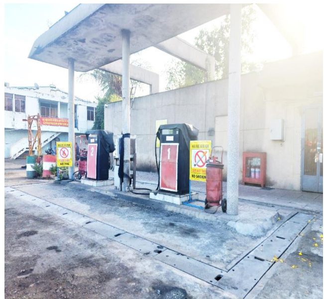
Trạm xăng dầu
