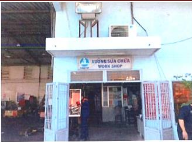
Xưởng sửa chữa cơ khí
