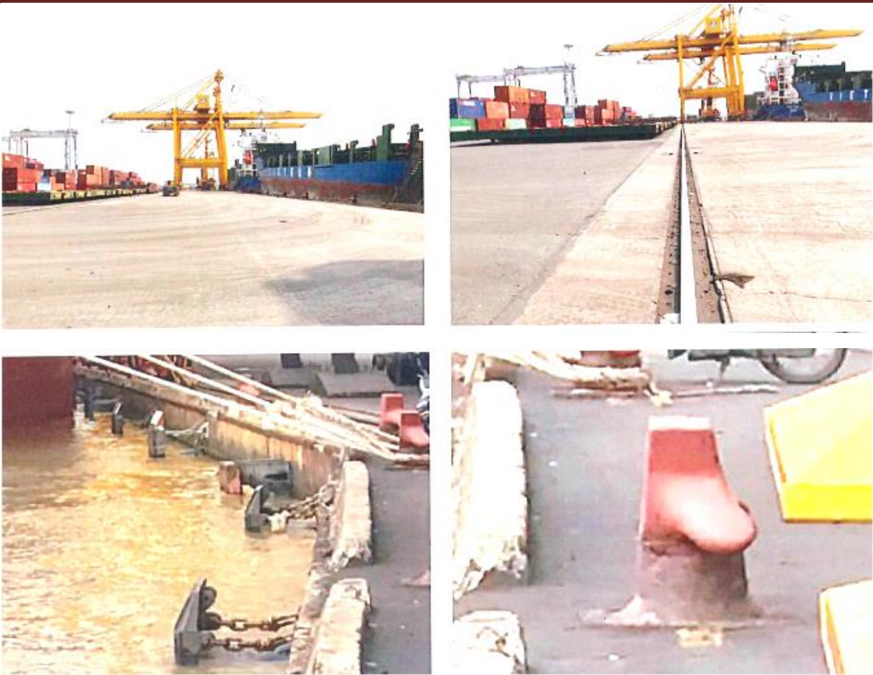
Hình 5. Hiện trạng công trình cầu cảng K15C
