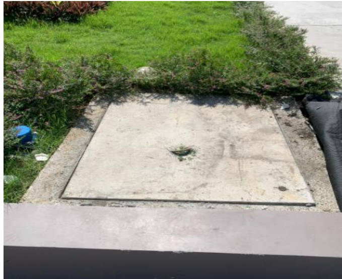
Hình 3.3: Hố ga thoát nước mưa
