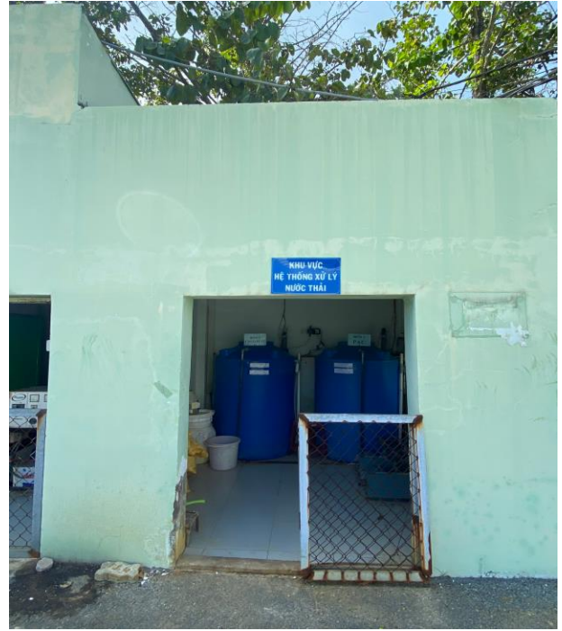
Hình ảnh khu vực hệ thống xử lý nước thải, công suất 70 m 3 /ngày.đêm của Bệnh viện
