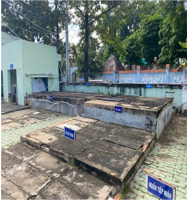
Hình ảnh khu vực hệ thống xử lý nước thải, công suất 70 m 3 /ngày.đêm của Bệnh viện
