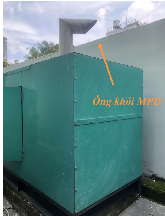
Hình 3. 6. Máy phát điện ngoài trời công suất 330kVA
