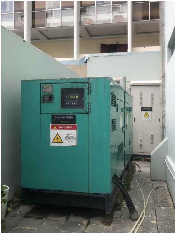
Hình 3. 6. Máy phát điện ngoài trời công suất 330kVA
