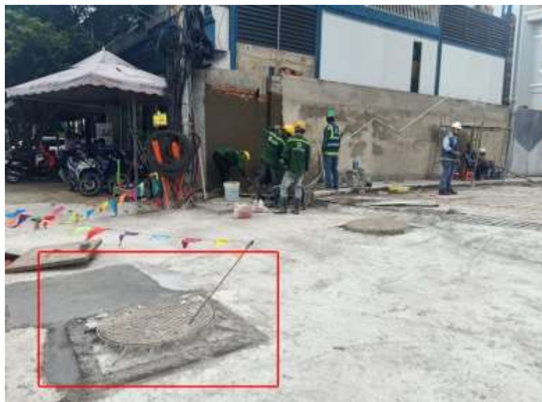
Hình 3. 2 Hố ga đầu nối của dự án
