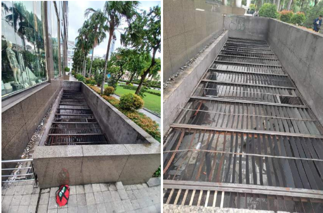
Hình 3. 5. Máy phát và lam thoát ống khói máy phát điện dự phòng
