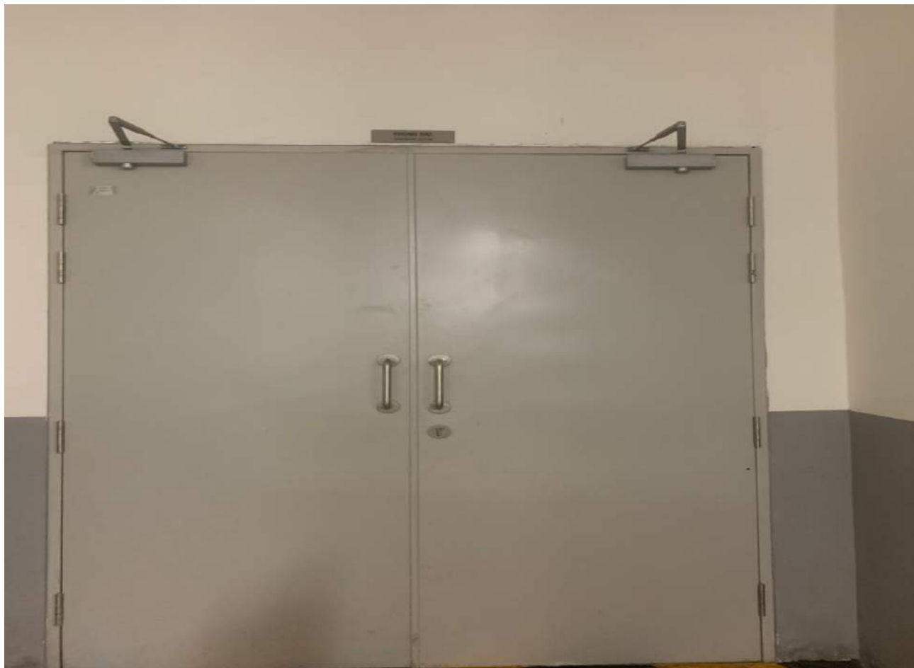
Hình 3. 22. Khu vực tập kết chất thải rắn sinh hoạt
