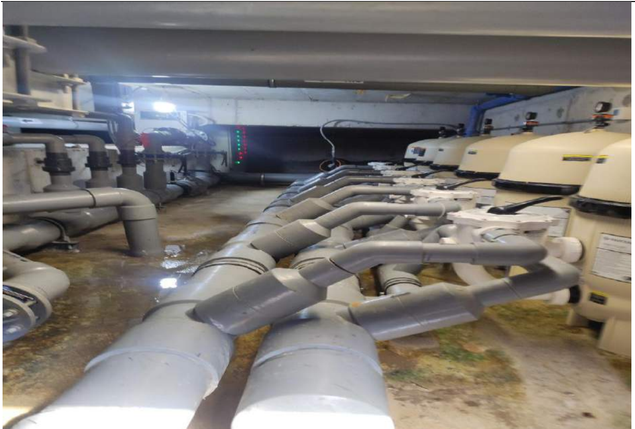
Hình 3. 14. Hệ thống lọc nước hồ bơi
