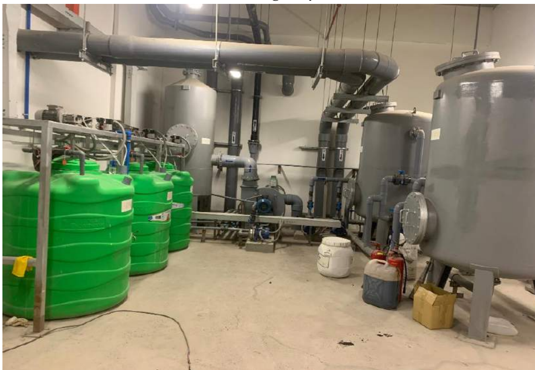
Hình 3. 12. Hình ảnh hệ thống xử lý nước thải của dự án
