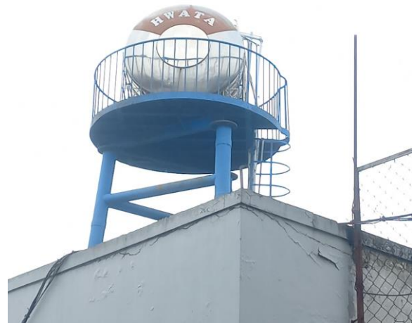
Bồn nước cấp
