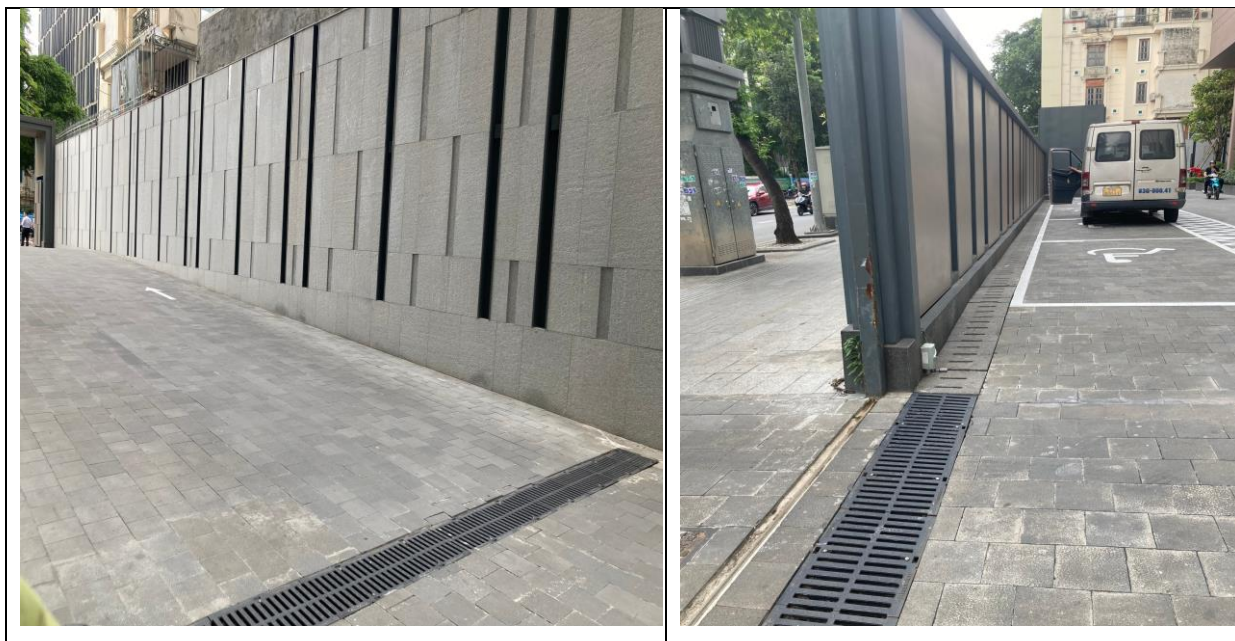
Hình 3.2: Hệ thống thu gom nước mưa dự án
