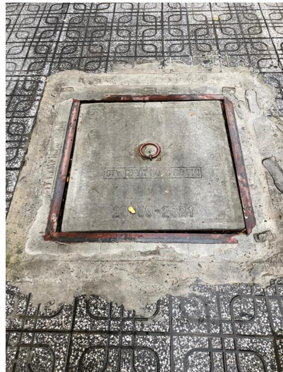
Hồ ga đầu nối nước mưa
