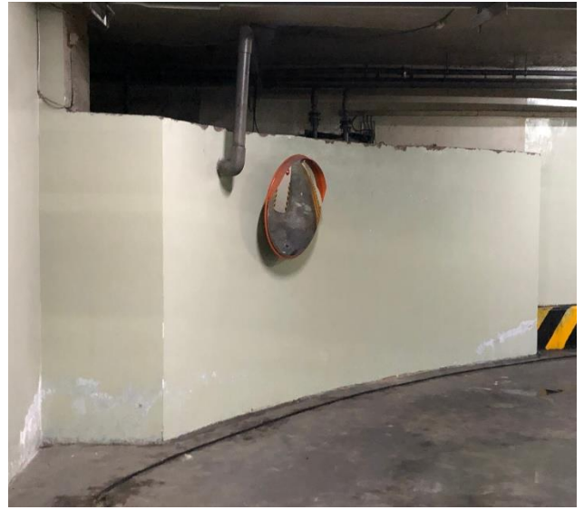
Bể tự hoại
