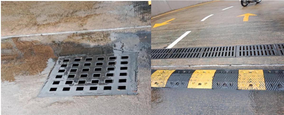
Hình 4. Hố ga nhỏ bố trí dọc khuôn viên sân, hành lang cơ sở.
