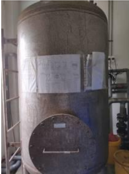
Thiết bị xử lý mùi và hóa chất sử dụng cho HTXLNT
