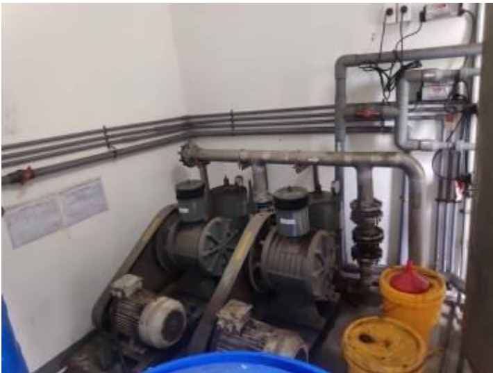
Cụm máy thổi khí và bồn hóa chất
