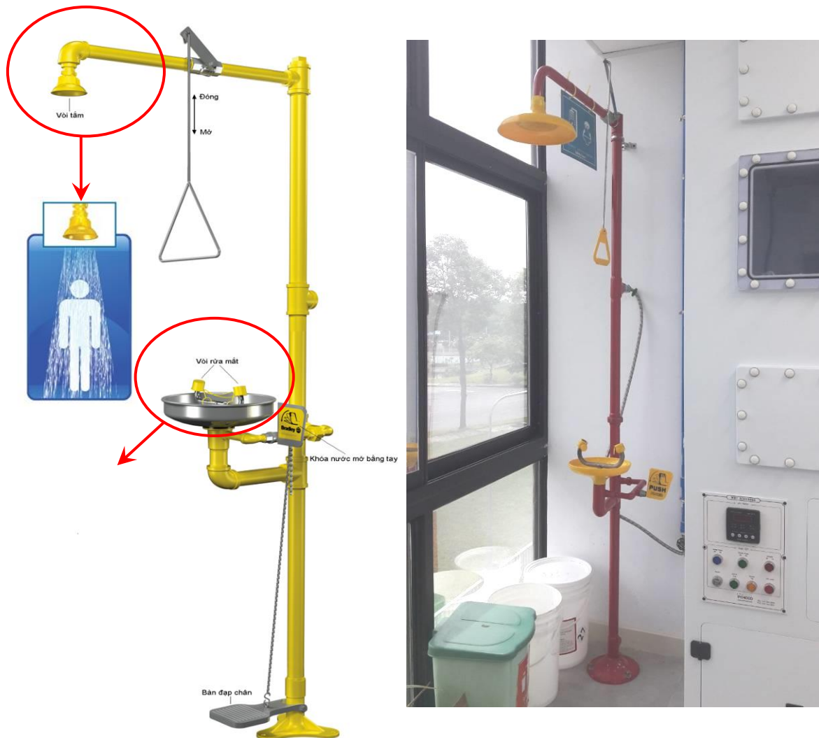
Hình 4.19. Sơ đồ cấu tạo và hình ảnh chụp thiết bị tắm toàn thân và rửa mắt được trang bị tại phòng thí nghiệm của dự án.
