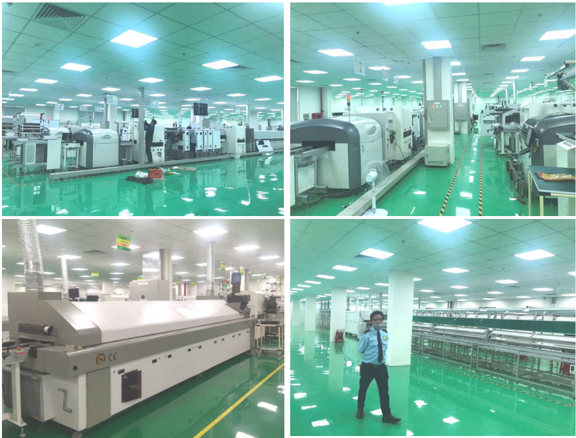
Hình 1.2. Một số hình ảnh minh họa dây chuyền máy móc đã được lắp đặt tại dự án.
